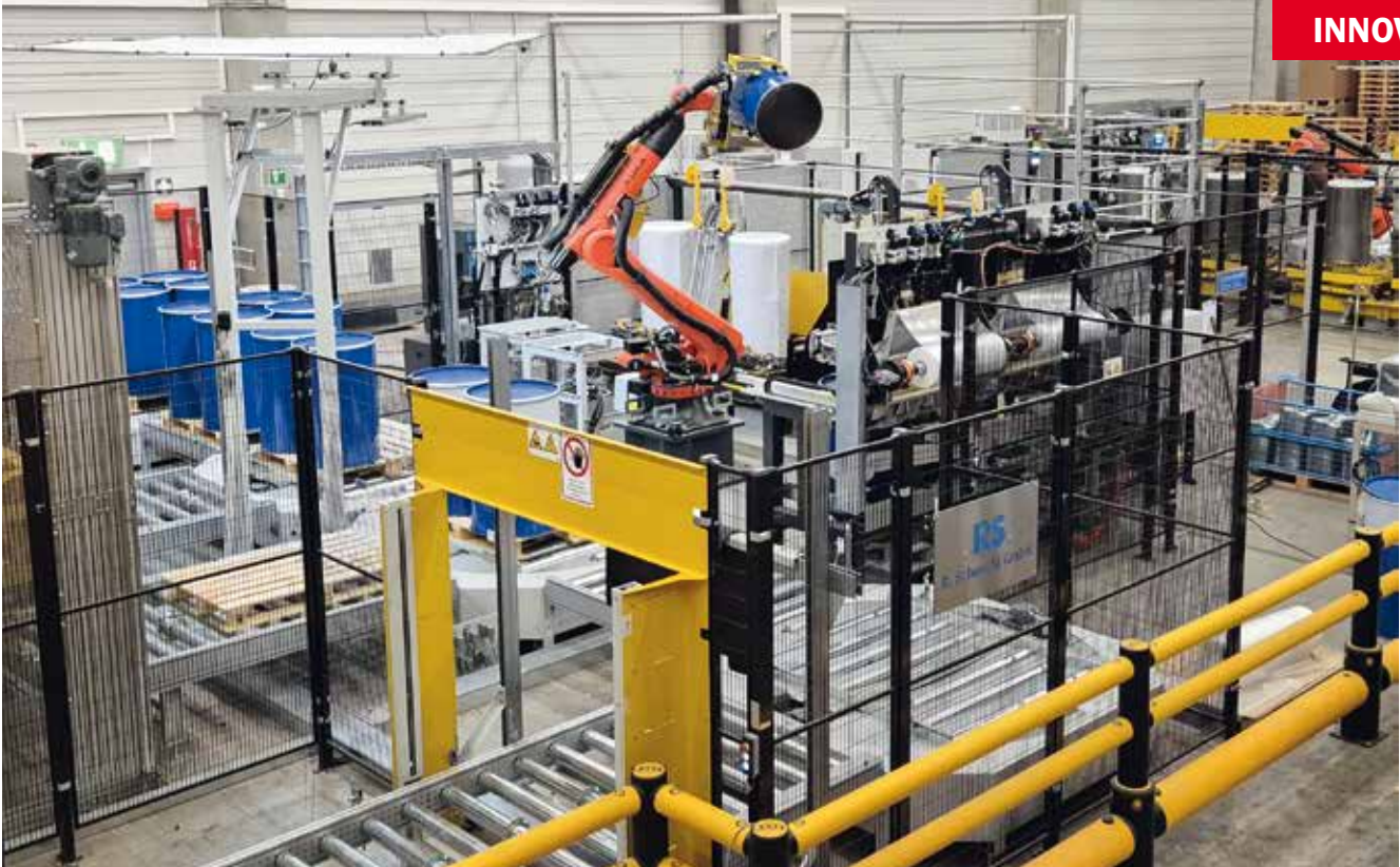
Verbessert die Sicherheit und erhöht die Effizienz - die teilautomatisierte Lösung am Standort Haiming.
